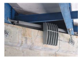
主桁端部 (鋼橋)
