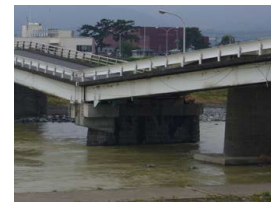
橋脚の沈下
