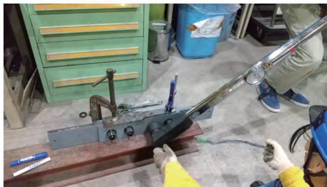
図-3 ボルト締めの実施状況
