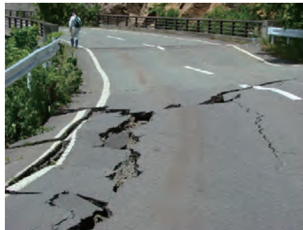
写真-1 過去の地震時に同じ路線区間で見られた構造物等の変状
