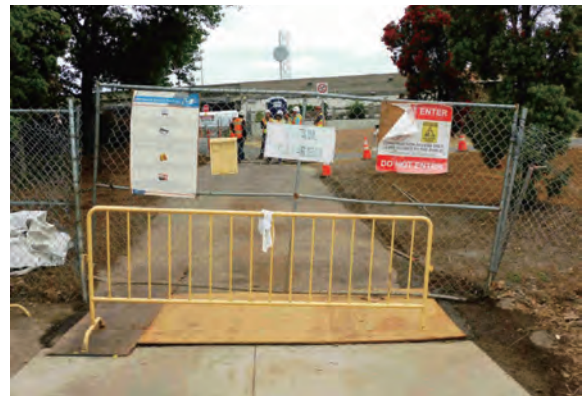
写真-11 朝のミーティング風景（補修工事中）
