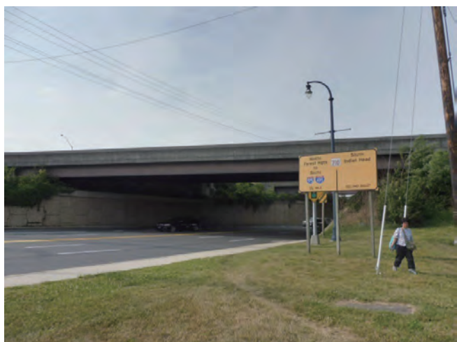
写真-4 橋梁全景と床版下面
