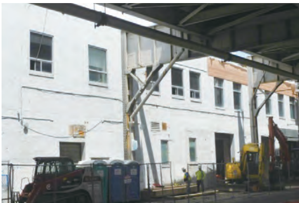
写真-8 ビルとビルの間に設置された鋼製橋脚
