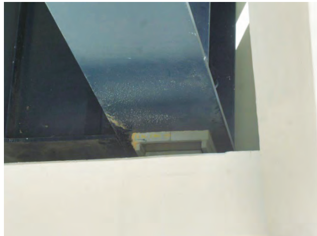
写真-7 コンパクトな支承
