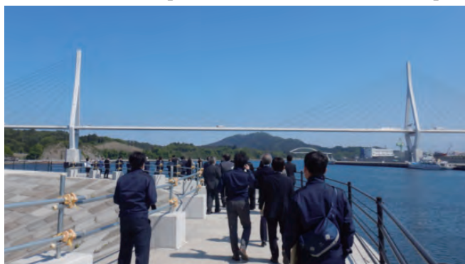
気仙沼湾横断橋 【説明：南三陸沿岸国道事務所】
