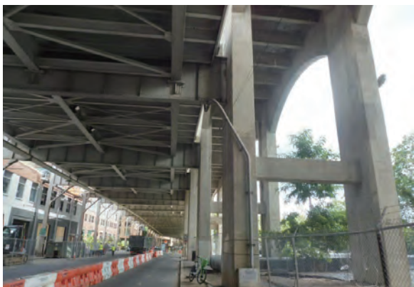
写真-9 隣接橋の支柱に鋼製横梁を剛結した構造
