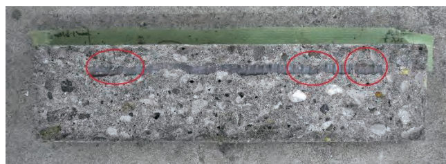
写真-1 予備試験体割裂による腐食確認状況 (塩水濃度 26%)
