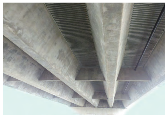
写真-13 床版下面
