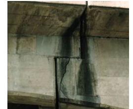
▲ゲルバー部の狭隘部
