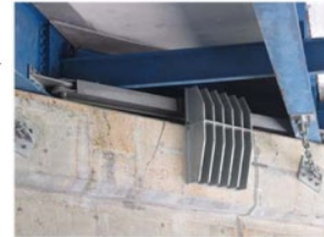
▲鋼橋桁端の狭隘部
