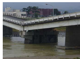
橋脚の沈下
