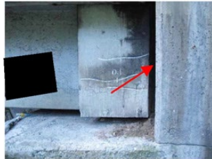
▲コンクリート橋桁端の狭隘部
