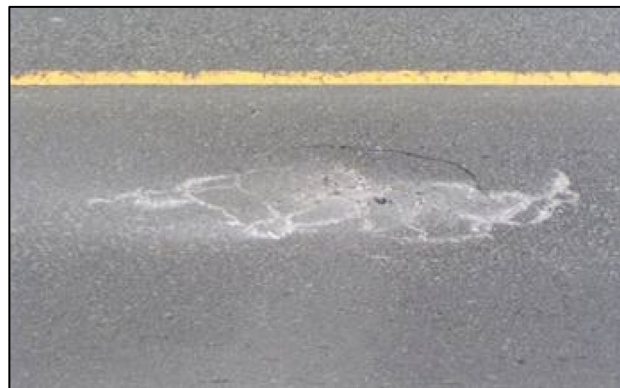
【舗装の異常(土砂化)】
